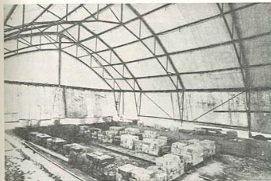
Fig. 2.01. Telt over byggeplads (Danmark).
