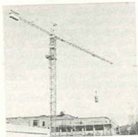
Fig. 6.24. Mørtelbeholder til transport med kran.
