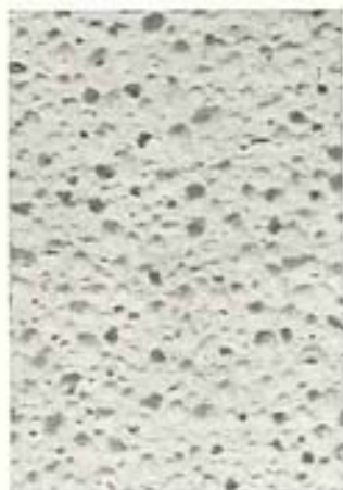
Fig. 2.05. Snit gennem porebeton med mange luftporer (ca. 1:1).
