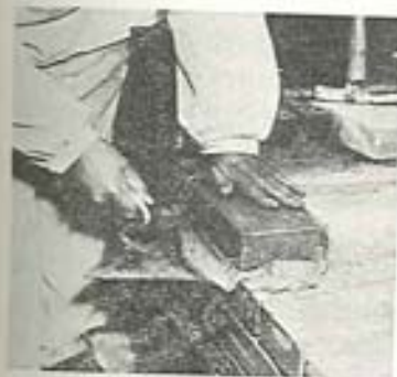
Fig. 8.19. Muring med fyldte fuger.
