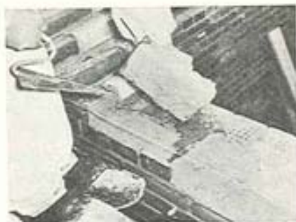
Fig. 8.20. Mørtel på «slagtets» sten.
