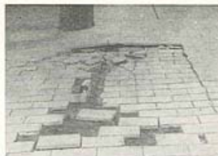
Fig. 2.33. Gulvfliser løsnet ved opbuling fremkaldt af dækkets svind og nedbøjning.
