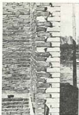
Fig. 8.11. Hul væg med fuldt udmuret dorfals med indlagt papstrimmel.
