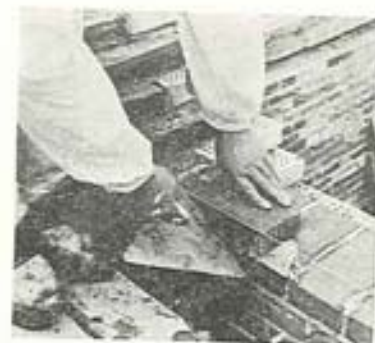
Fig. 8.19. Muring med fyldte fuger.
