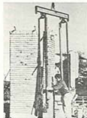
Fig. 8.26. Montering af teglelement.
