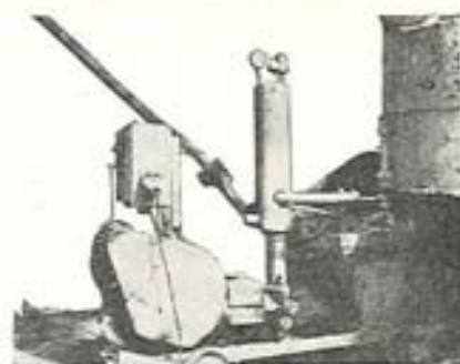
Fig. 6.25. Pumpe til mørteltransport i rør (det skrå) fra blandestation til stillads.
