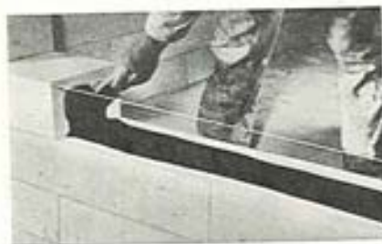
Fig. 8.27. Limfuge i mur af planfrasede porebetonblokke.
